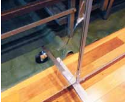
▲ 割れてしまったガラス製ミラー
